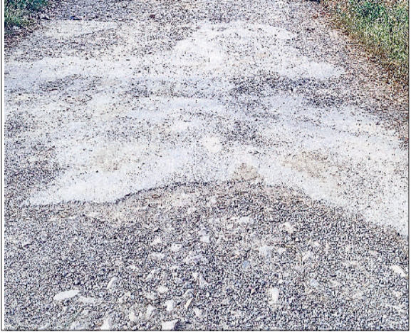
मुरम्मत का कार्य रुकने से क्षतिग्रस्त अवस्था में पड़ा गढ़ी केसरी से बड़ी संपर्क मार्ग। गन्नौर। रोड़े बिछाए बिना सड़क की रिपेयरिंग कार्य करते मजदूर।
